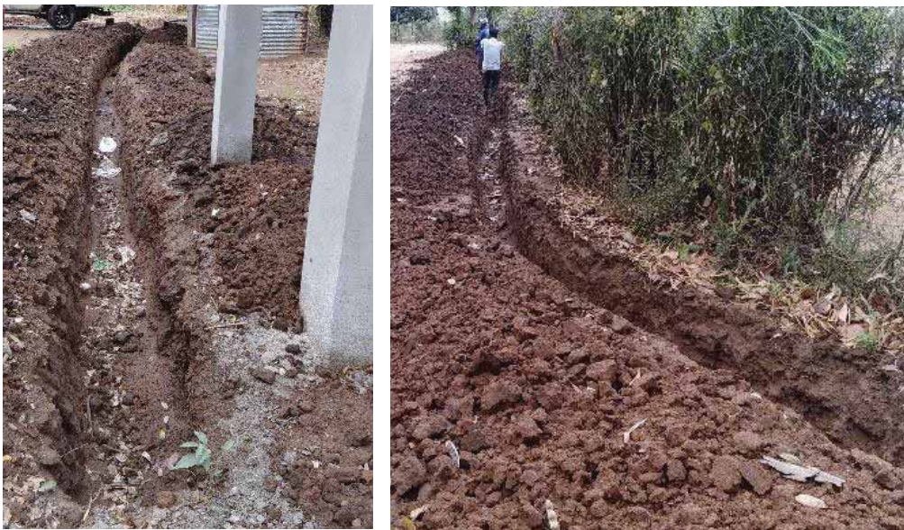
Zanjas para la colocación de las canalizaciones.
