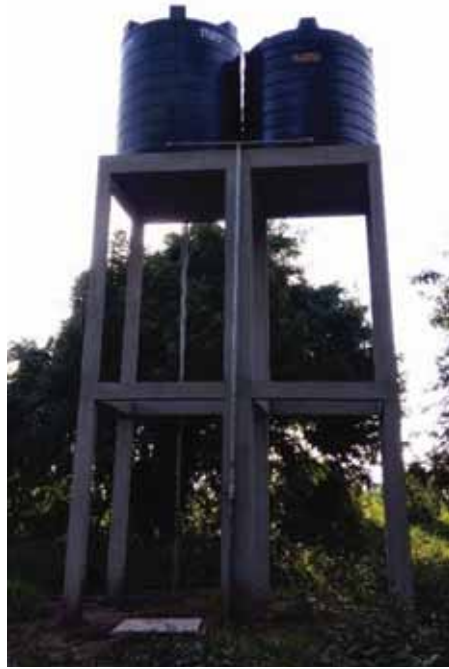
Depósitos, tubo de llenado en la parte de atrás y de bajada en la de delante.
