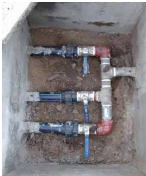
División de la red, la de arriba se dirige al campo grande de cultivo 1 de la agraria, la de en medio a casa de los Padres y la última al campo de cultivo 2 de la agraria.
