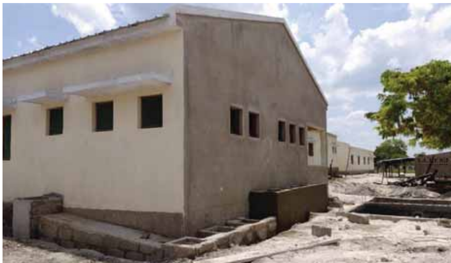
Vista exterior del baño, con las arquetas y la fosa a la dcha.
