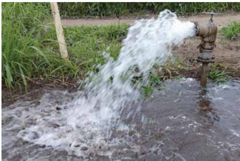
Hidrante que conecta la válvula del campo de fútbol con el campo de cultivo 1 de la escuela agraria.
