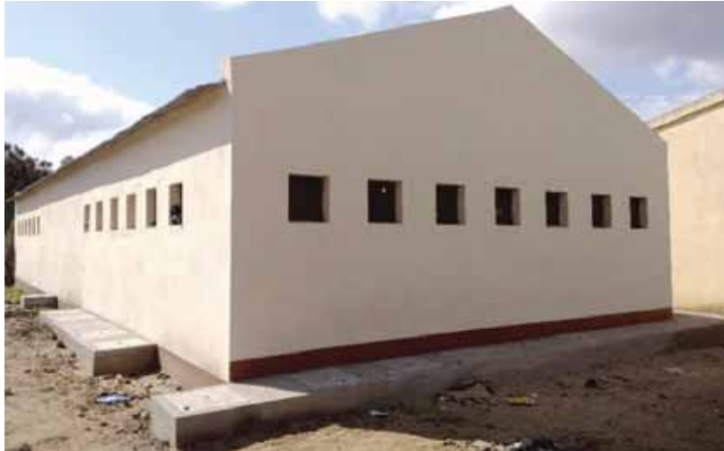
Vista exterior de la parte izq. y trasera del baño.
