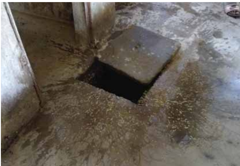
Arqueta en el interior de los baños.
