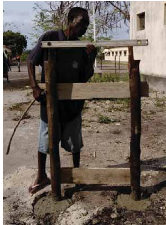
Nivelación para asegurar la verticalidad.
