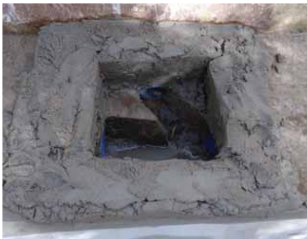
Arqueta en construcción.
