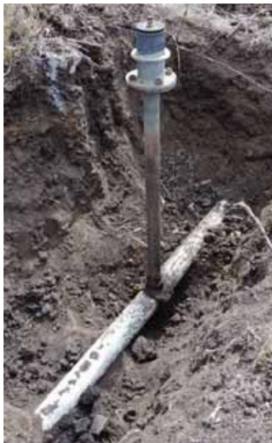
Hidrante que conecta la válvula del campo de fútbol con el campo de cultivo 1 de la escuela agraria.
