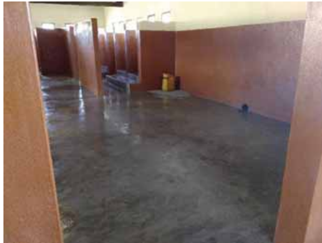
Vista letrinas. NOTA: Desagüe duchas en la parte central.
