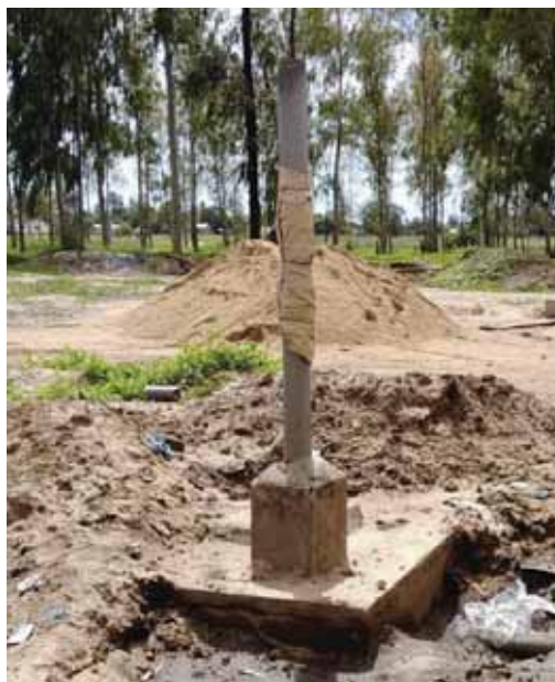
Fosa rehabilitada para las duchas.
