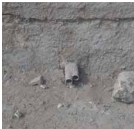
Salida canalización duchas instituto medio.
