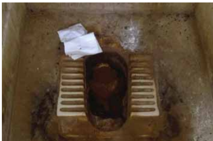
Letrina en el interior de los baños.
