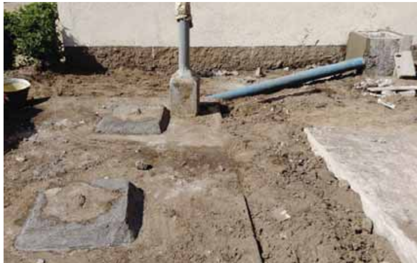
Fosa rehabilitada duchas.
