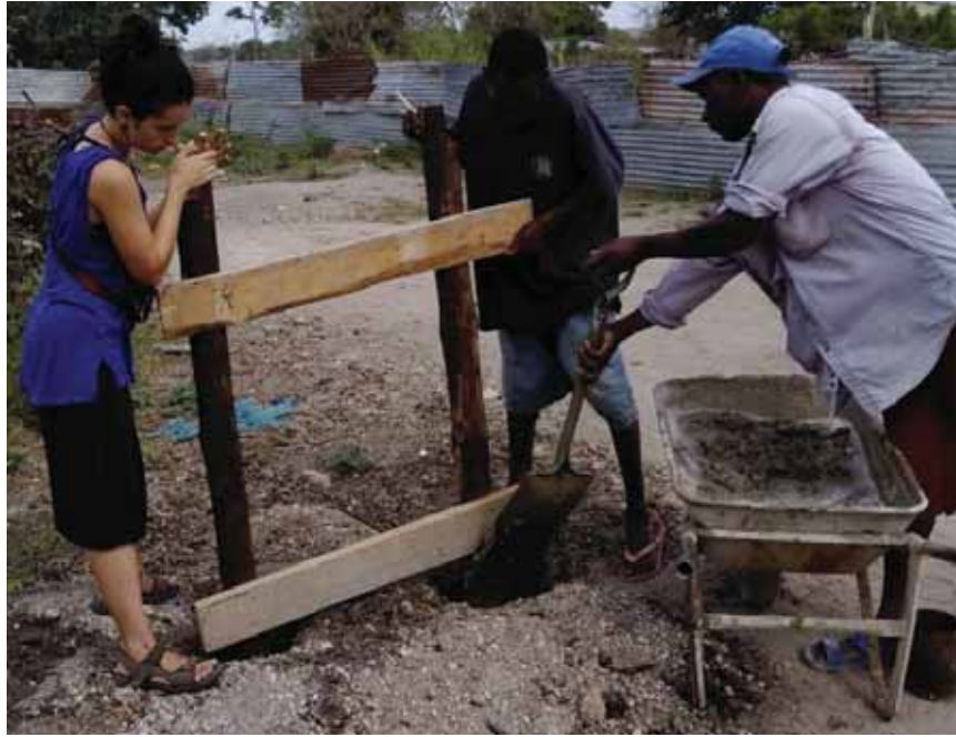
Colocación de la estructura.
