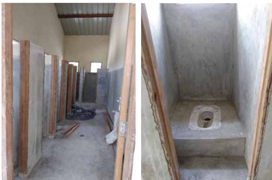
Interior del baño a la izq. y una de las letrinas a la dcha.
