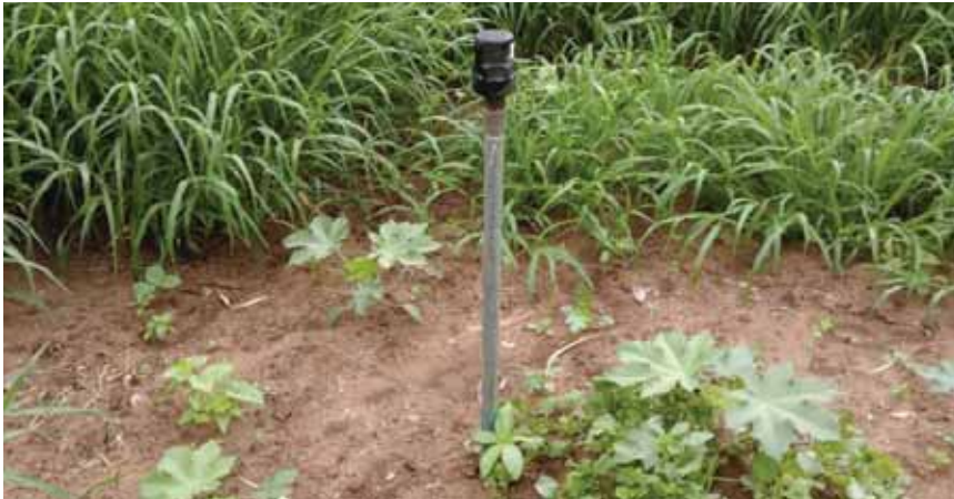
Válvula situada al lado del depósito que abastecerá la red de irrigación del campo de cultivo 1.
