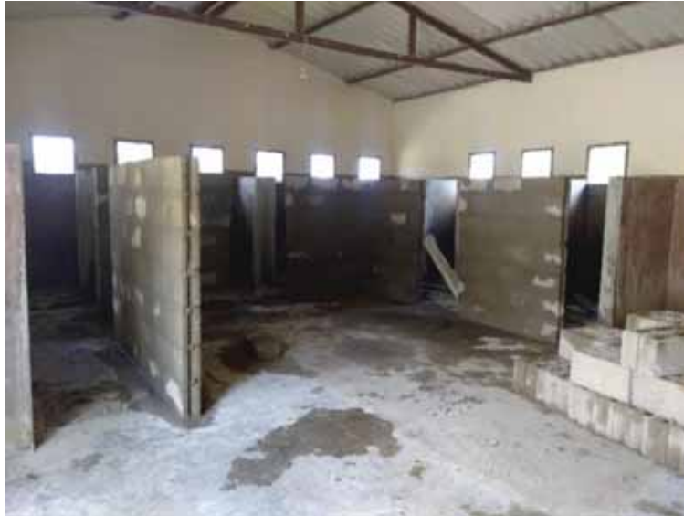
Interior del baño, zona de letrinas.
