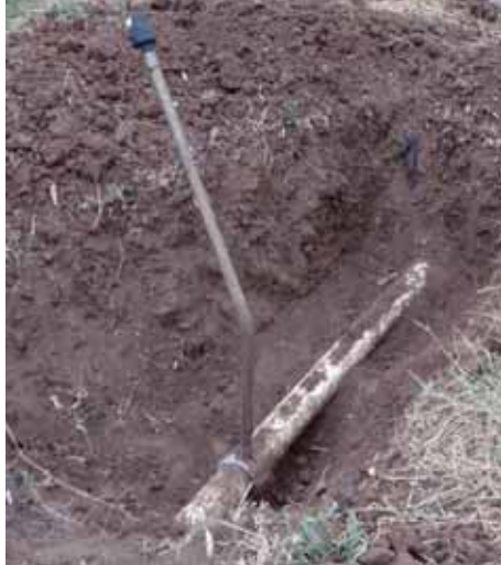
Válvula situada al lado del depósito que abastecerá la red de irrigación del campo de cultivo 1.
