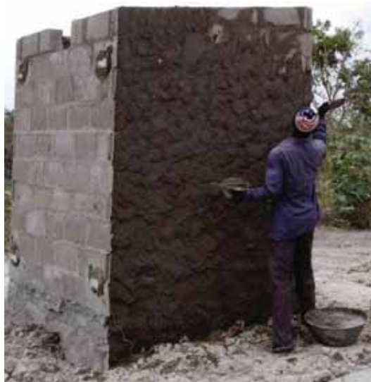
Enfoscado de las paredes de una de las dos letrinas.
